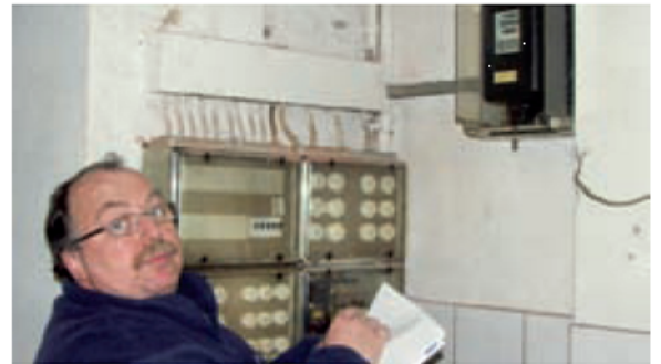
Auch das Ablesen von Zählerständen gehört zum Job.
